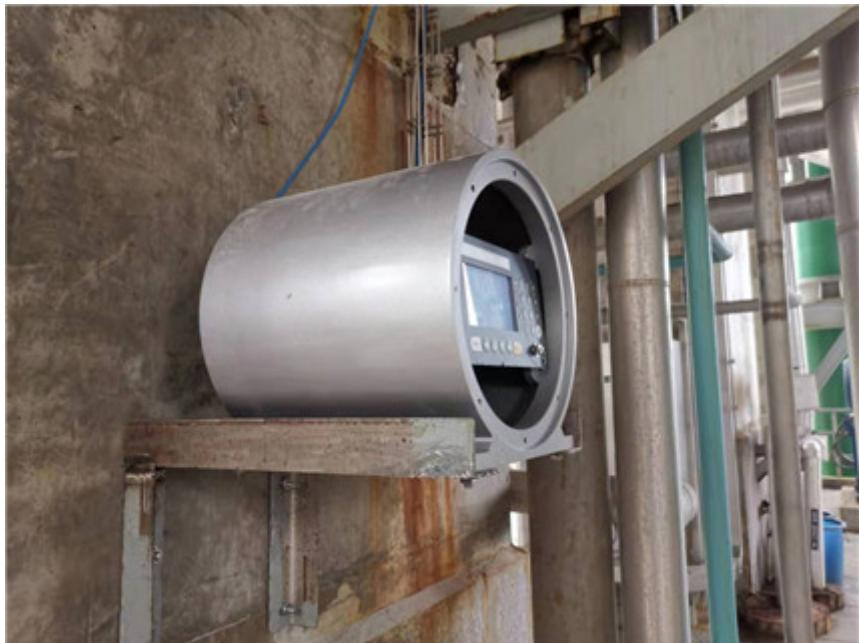
使用多了，成本上升，少了达不到环保要求。所以检测尾氯浓度对节约成本很有必要。氢气排放使用碱液来吸收。连续监测尾氯浓度，烧碱浓度监测，副产品 $\text{NaCl}\square\text{NaOCl}\square\text{NaNO}_2\square\text{Na}_2\text{CO}_3$ 等浓度监测。盐酸生产的检测，电解器阳极生产的氯气和所添加氢气是合成盐酸的基材。将两种气体注入一个燃烧器，这两种气体将在燃烧器内反应形成氯化氢，这后所形成的氯化氢气体从燃烧室蒸发进入一体式等温降膜式吸收器。在此氯化氢气体通过水和稀 $\text{H}_2\text{SO}_4$ 液吸收，并形成浓缩盐酸 $\square 37\text{HCl}\square\square$ 连续监测盐酸（20-40）浓度 $\square\text{H}_2\text{SO}_4$ 浓度监测。
